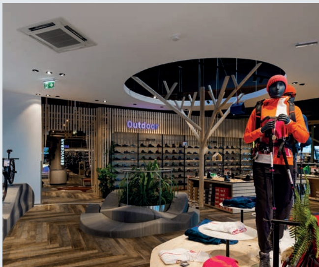
Nákupné galérie PADO v meste Pamdorf, CAVERION Österreich GmbH Klimaanlage und Wärmepumpen
