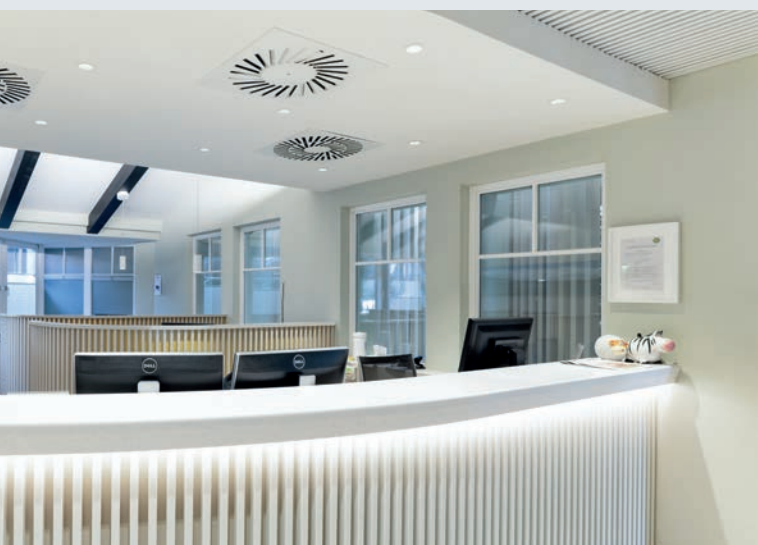
Zdravotné stredisko Park Igls v Innsbrucku, EDMUND SPARER Klima & Kältetechnik GmbH
